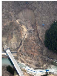
写真1 空中写真 地すべり規模：幅 70m、長さ 200m。
